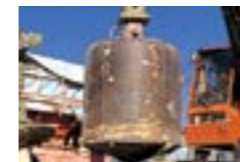
ドリリングバケット掘削作業
